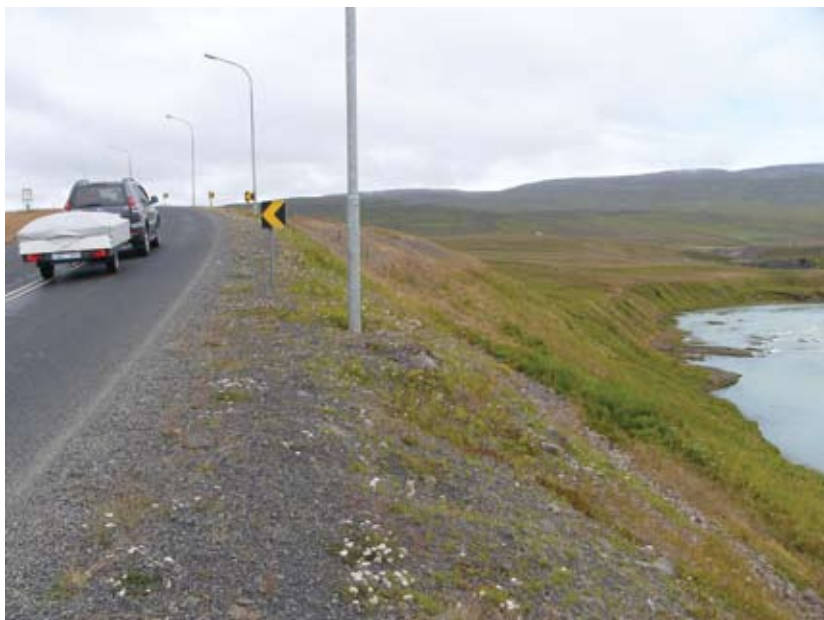
Vegur nr 1, hringvegurinn skammt norðan við Blönduós. Engin vegöxl hár og brattur kantur sem endar í Blöndu. Hér hefur ekki orðið slys - ennþá.
