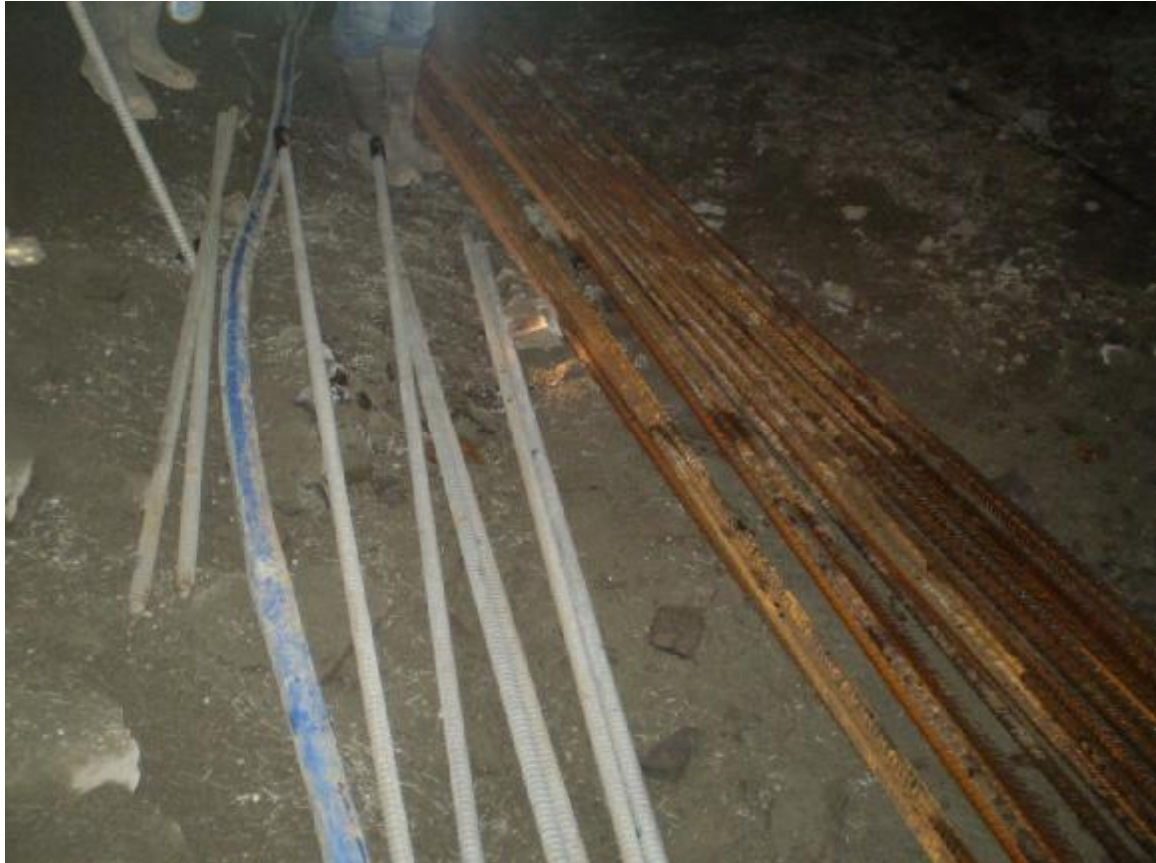
Mynd 6. Boltar sem setja á upp er oft fleygt á gangagólf framan við stafn ganga. Meðhöndlun sem getur skaðað ryðvörn boltans.
