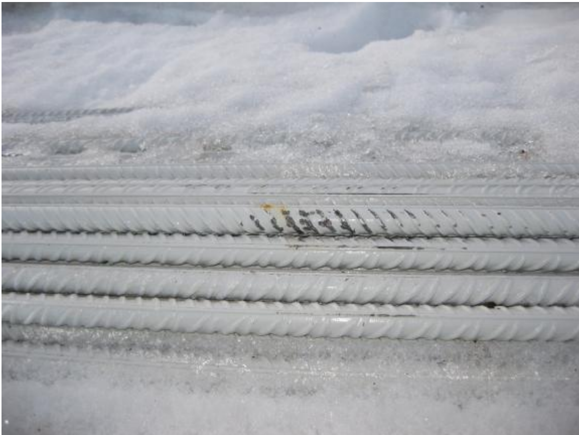
Mynd 5. Boltar sem liggja óvarðir fyrir utan gangamunna geta orðið fyrir skemmdum.
