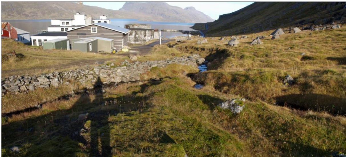
Mynd 33. Stórgrýti í veglínu 708, horft til lækkandi stöðva frá stöð 10120 við Djúpuvíkurá (Ljósmynd: Ómar Bjarki Smárason, 2019).
