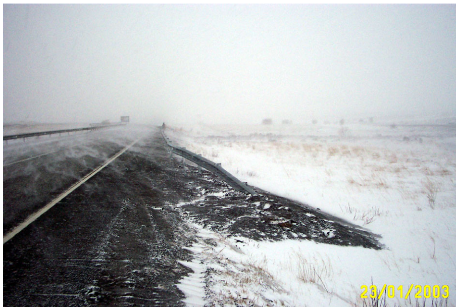
Mynd 11. Vegrið við hægri vegarkant austan Hólmsár. Ferill vegriðs er þannig í grófum dráttum að fyrstu 10 m frá brúnni eru samsíða vegi, næstu 35 m liggja skáhalt út frá vegi þannig að vegrið gengur u.þ.b. 1 m út frá upprunalegri línu og á síðustu 10 m er vegrið fært niður í fyllingu og víkur um 2 m til viðbótar frá vegi. Vegriðsendinn er því í 4 m fjarlægð frá kantlínu vegar. Talið er að þetta fyrirkomulag muni minnka snjósöfnun inn á veginn og auðvelda snjóhreinsun.
