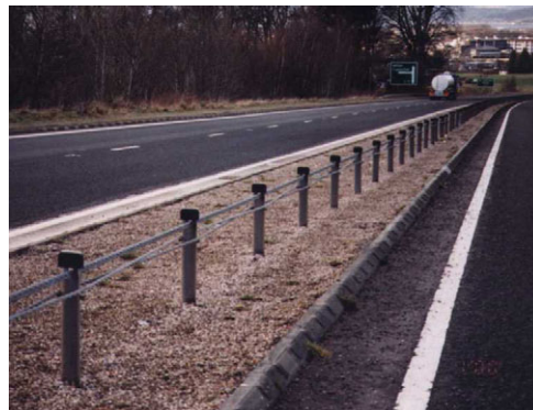
Mynd 6. Vinstri: Vegrið af Kohlswa-gerð. Hægri: Víravegrið. (RoadEx, 2001)
