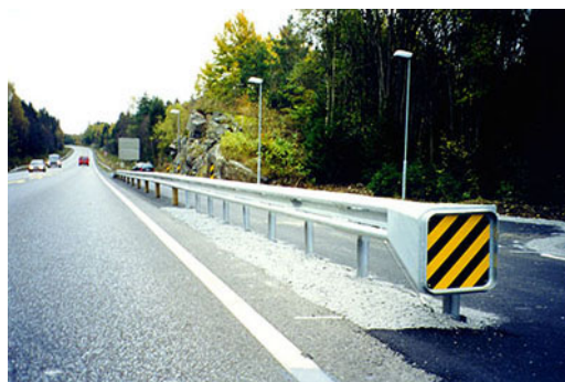
Mynd 7. Vinstri: Kassalaga vegriðsbiti (RoadEx, 2001). Hægri: Vegriðsendi með ákeyrsluöryggi, ABC-Terminalen (Euroskilt AS)
