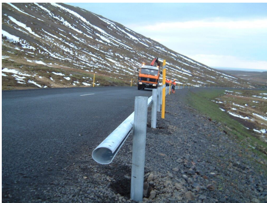
Mynd 16. Unnið við uppsetningu Sicuro rörovegriðs á Vatnaleið á Snæfellsnesi. Hér er annað rörið af tveimur komið á réttan stað.
