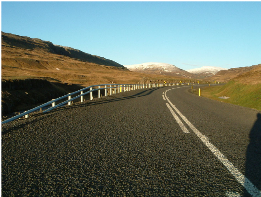
Mynd 17. Röravegrið við nýjan veg yfir Bröttubrekku.
