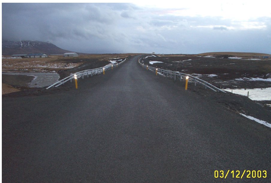
Mynd 15. Rörovegrið á ræsi yfir Hofsa í Skagafirði, séð til suðurs. Endar vegriðs eru dregnir vel út hliðar á breikkaða fyllingu.
