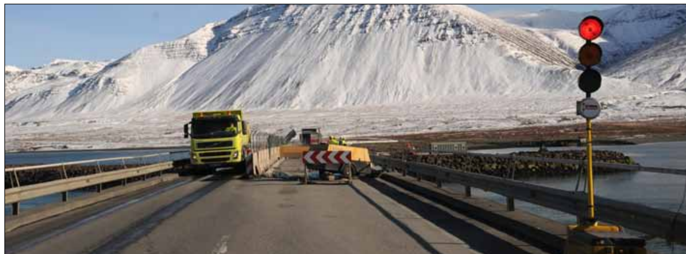
Vegna framkvæmda við brúargólf Borgarfjarðarbrúar er lokað fyrir umferð á annari akrein á hluta brúarinnar. Notast verður við ljósastrýngar fyrir umferð. Framkvæmdir munu standa yfir frá 2. maí til 13. júní. Myndin var tekin við samskonar framkvæmd vorið 2013.
