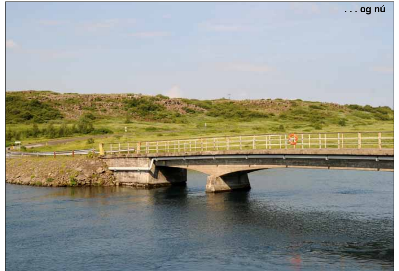
Vesturendi brúarinnar yfir Sogið hjá Írafossi. Sjá má hvað lónið fyrir ofan virkjunina stendur hátt miðað við brúarstöpulinn. Myndin er tekin sumarið 2013.
