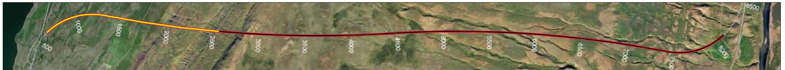
Vaðlaheiðargöng, staða framkvæmda 3. mars 2014. Búið er að sprengja 1.936 m frá Eyjafirði sem er 27% af heildarlengd.
