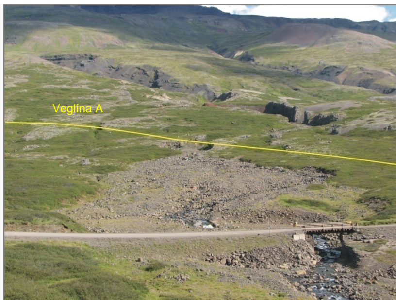
Mynd 3.2.4. Mynd sem sýnir hvar veglína A fer yfir Selá. Efst hægra megin á myndinni er Efra-Rauðafell og Illagil þar beint fyrir neðan (Ljósmynd: Hafdís Eygló Jónsdóttir, 2008).
