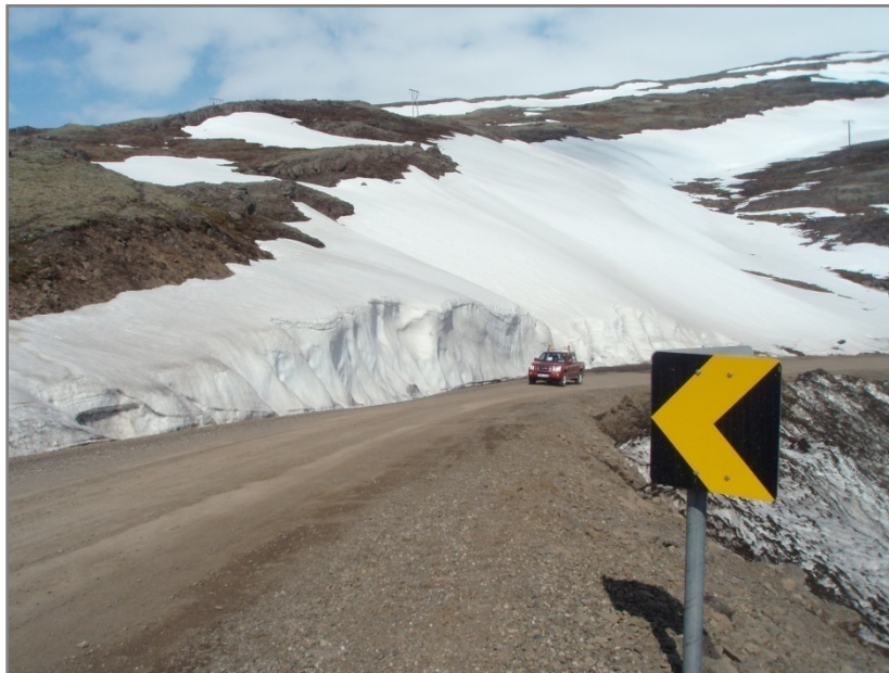
Mynd 2.4.2. Myndarlegur snjóskafl í Háubrekku 21. maí 2008. Einn þriggja helstu farartálma á núverandi vegi þar sem snjó skefur þvert á veglínu (Ljósmynd: Einar Sveinbjörnsson).
